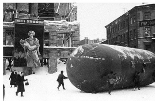
Транспортировка газгольдера на углу Лиговского проспекта и Разъезжей улицы. 1943 г.
